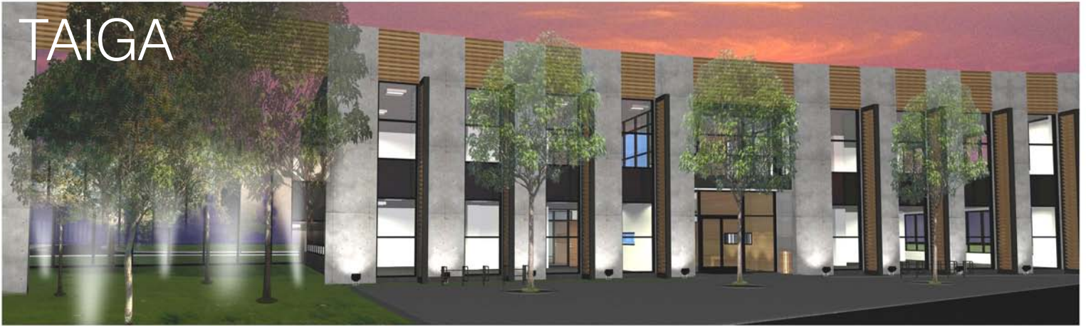
VUE FACADE OUEST - ENTREE BATIMENT
